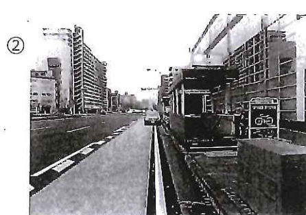
地上階 北東出入口付近
